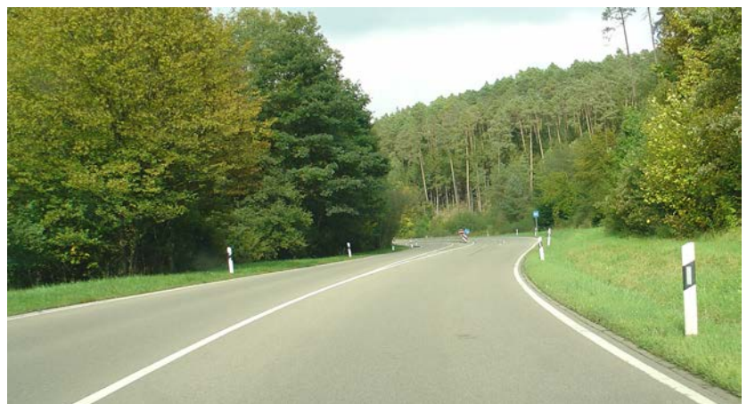
L1208 Bebenhausen Richtung Dettenhausen, Beginn des 3-spurigen Ausbaus
