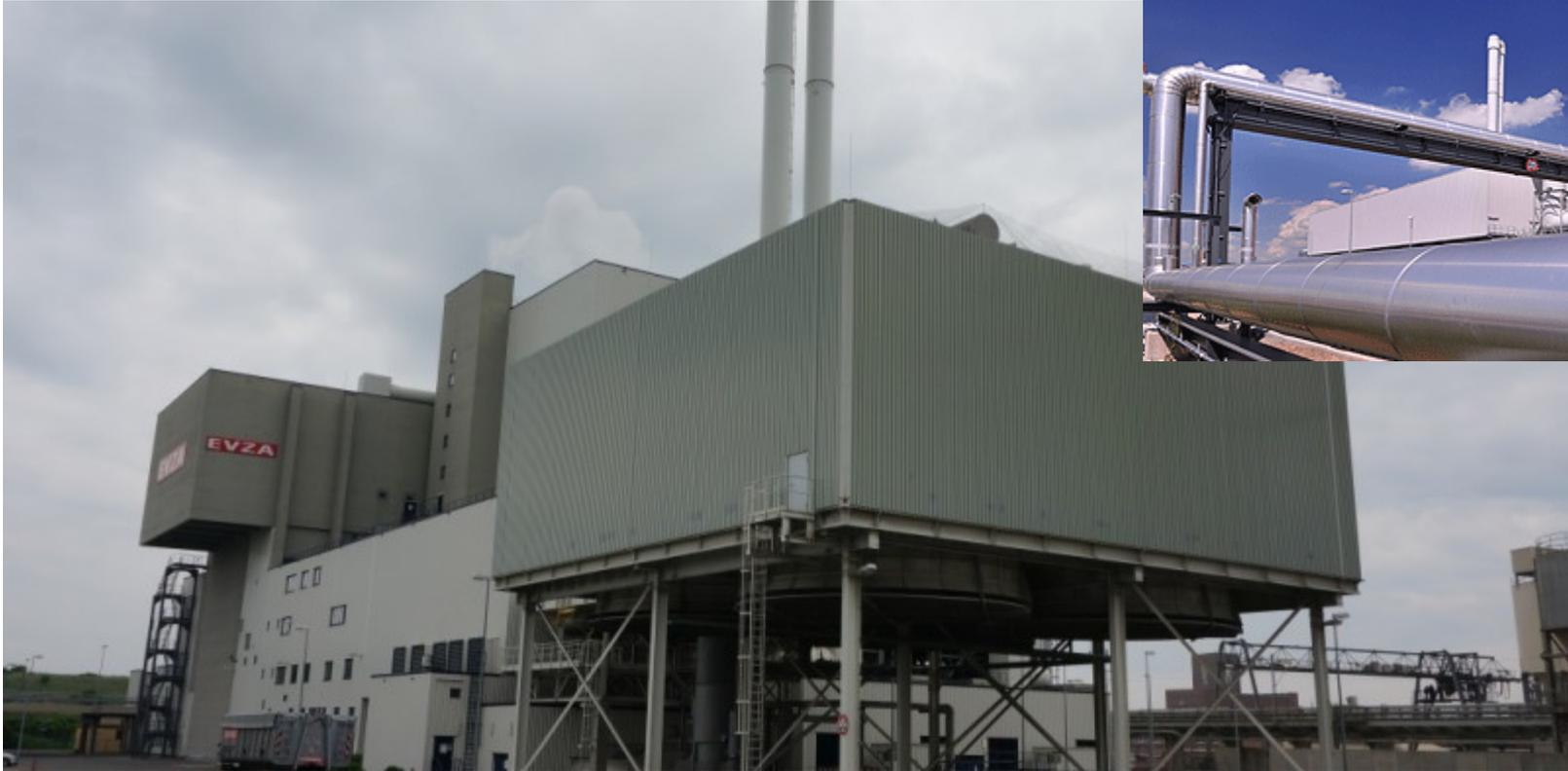
Starke Volumenreduktion; freigesetzte Verbrennungsenergie wird als elektrische Energie, Wärme und/oder **Prozessdampf** zur Erzeugung von Fernwärme genutzt. **Schlacken** für Bauwirtschaft; **Filterrückstände** der Rauchgasreinigung mit Schadstoffen angereichert - Deponie
