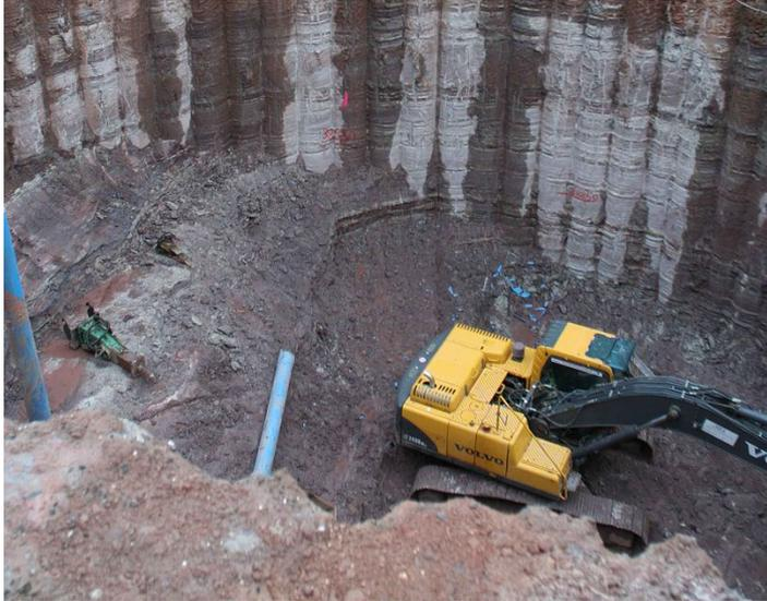
Bohrung wird verrohrt ausgeführt oder es kommt eine Stützflüssigkeit aus **Bentonit-Zement Suspension** zum Einsatz. Die Stützflüssigkeit wird laufend nachgefüllt, kompensiert den Erddruck und dichtet das Bohrloch ab
