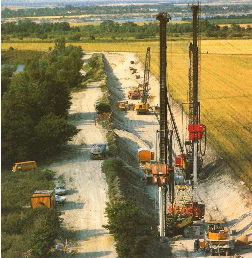
Hohlräume werden gleichzeitig mit Dichtungsmaterial verfüllt (meist Bentonit-Zement-Suspension mit Steinmehl)
